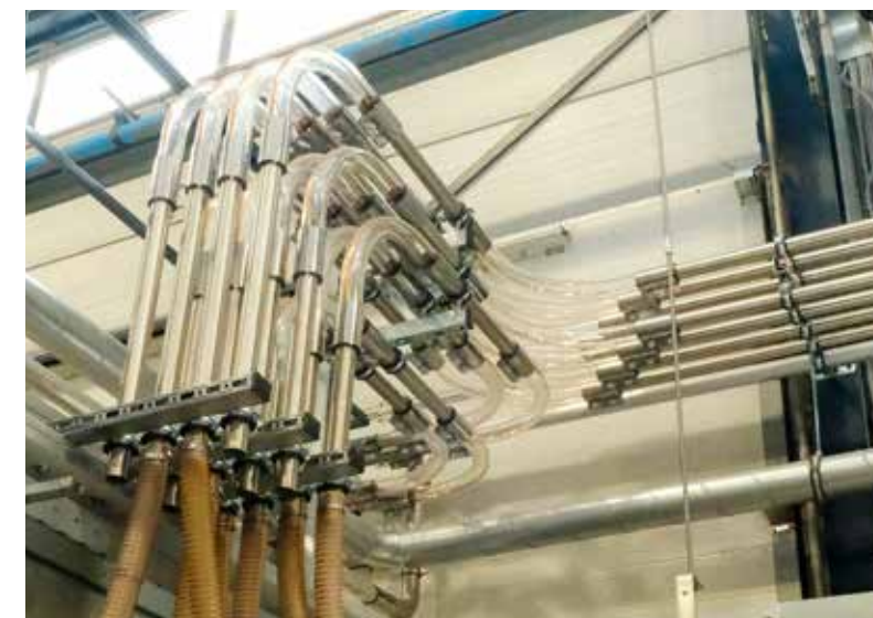
Het granulaat-transportstelsel met glazen bochten, vanwege hoge slijtage door glasgevuuld PA.
