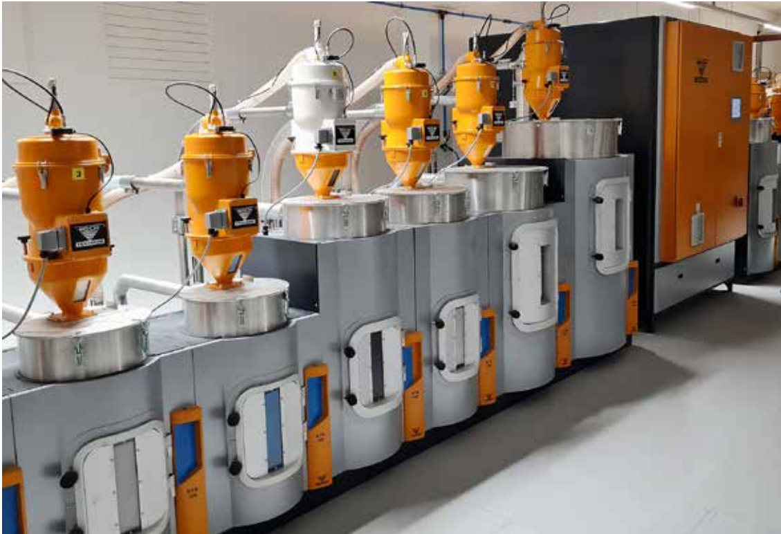
Geen leidingen over de fabrieksvloer, maar via de parkeerkelder. Gekoppeld aan een centrale droger met automatisch koppel- en wisselstation is alle granulaat altijd droog en gaat altijd naar de juiste machine.
